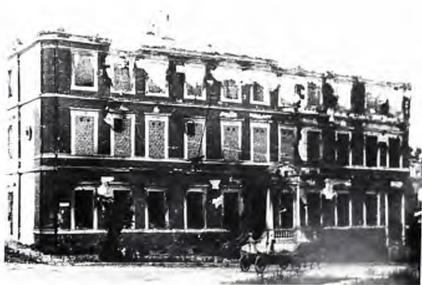
Postamt mit zugemauerten Fenstern
