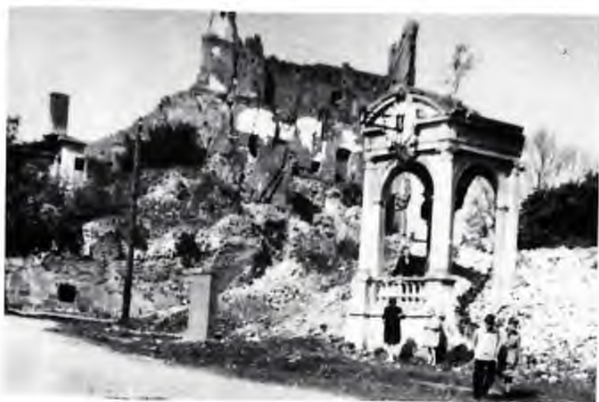
Postamt nach dem Abriß (nur der Eingang mit Säulen steht noch) Im Hintergrund Reste des Steinhauses
