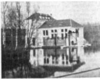
Kraftwerk der Mühle Wichert Aufnahme: Eduard Fischer
